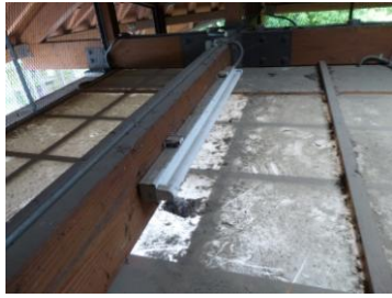
照明器具移設前
