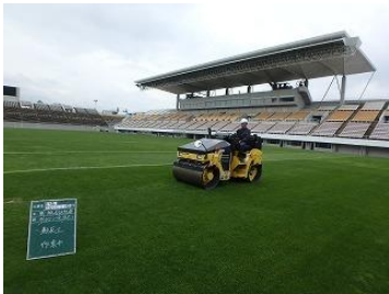
作業状況(総合球技場)
