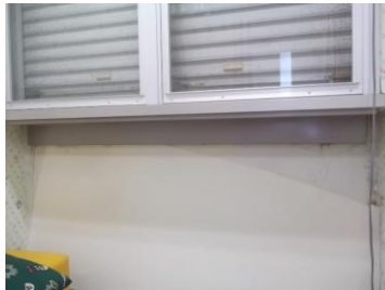
既設クロス剥がし・ 三方枠周囲コーキング
