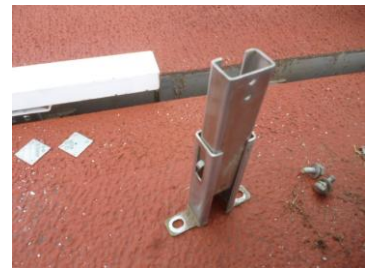
ラッチ部脱落確認
