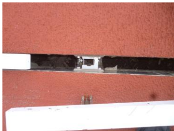
昇降固定不良
