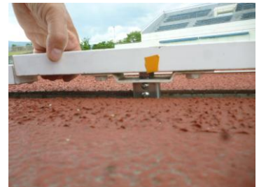
ビス取付け完了
