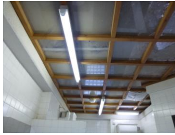
照明器具移設後
