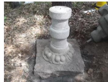
中間支柱石設置作業
