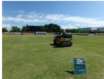
作業状況(陸上競技場)
