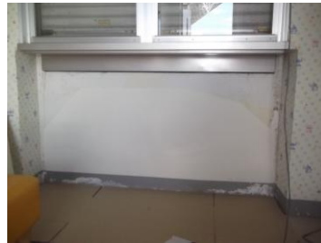
クロス剥がし・下処理施工
