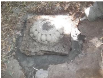
土台石設置作業中
