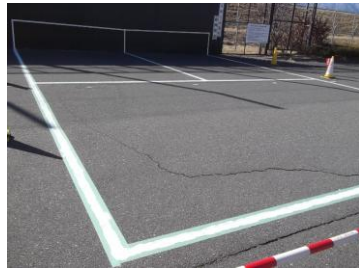
ハードライン(白色)塗装施工
