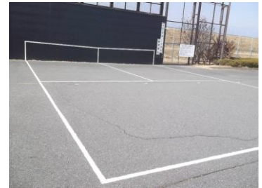
北面コート 施工完了
