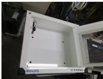
AED 収納箱ヒーター取付前 (陸上競技場)
