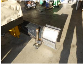
溶接取付け作業拡大
