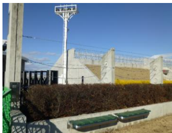
南サイド メッセンワイヤー張り完了 1
