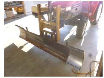
溶接取付け作業
