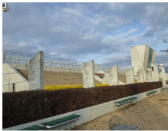
南サイド施工前
