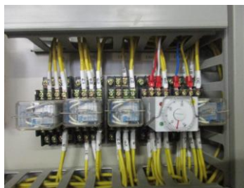
消火水槽警報 取替後
