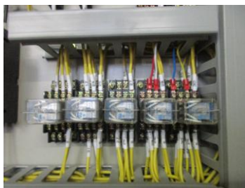
消火水槽警報 取替前
