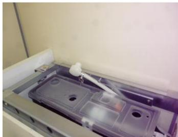
給湯器の逃し配管が脱落
