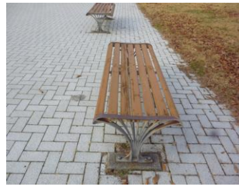
着手前状況拡大
