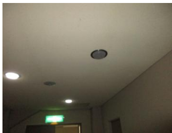
ランプ交換前
