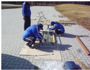
分解 座板取付け
