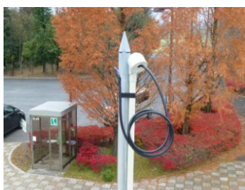
配管・通線状況
