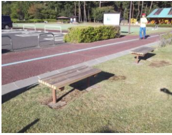
木部高圧水洗浄完了
