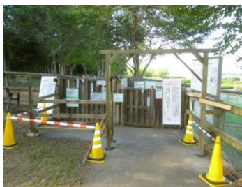
フェンス部支柱組立て
