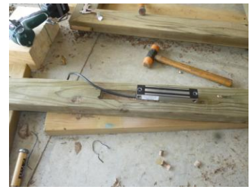
電気錠埋め込み
