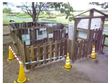
フェンス板貼り
