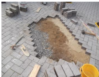
碎石・客土・砂敷状況
