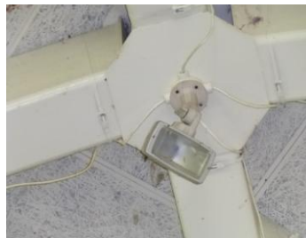
照明器具取替前
