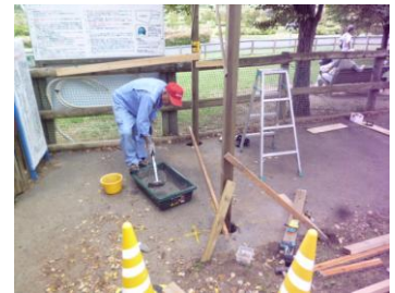
柱建て方・コンクリート根巻き
