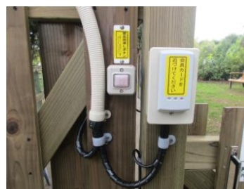
電気錠 出口カードリーダー・ 緊急用押しボタン
