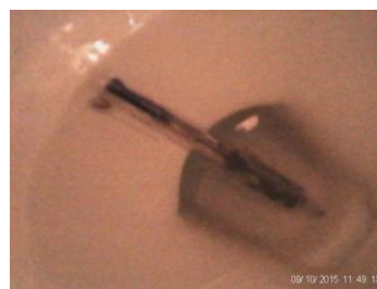
ボールペン引抜き状況
