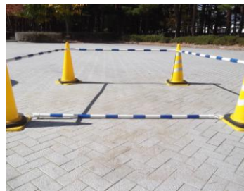
インターロッキング敷込み完了
