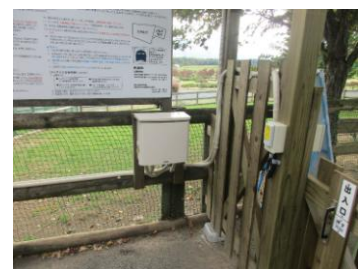
電気錠制御盤
