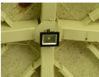
照明器具取替完了
