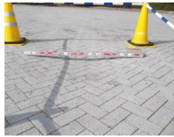
インターロッキング敷陥没状況
