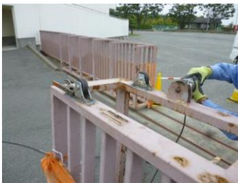
破損戸車取外し
