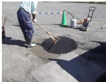
アスファルト骨材充填作業中
