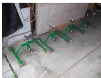
SP ヘッド・消火ホース 接続金具取付
