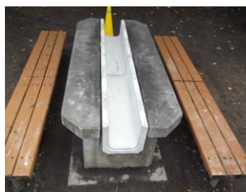
新規コンクリートU字溝設置
