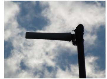
アンテナ取付完了
