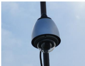
カメラ取付完了
