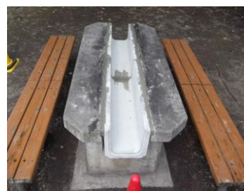
コンロ台との隙間モルタル充填
