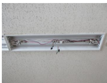
ソケット取替状況
