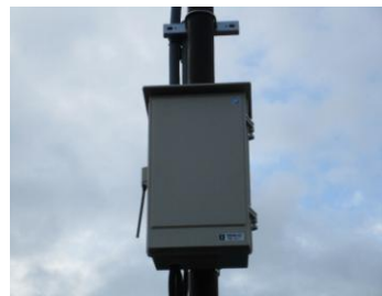
機器収納箱取付完了
