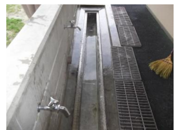
側溝内清掃完了
