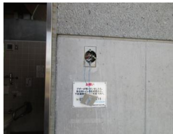
4号トイレ呼出表示灯 取替中
