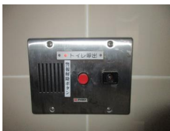
4号トイレ呼出 呼出表示装置 取替前
