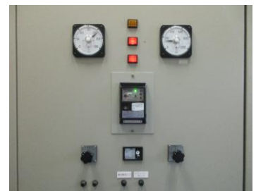
QB 低圧動力用 LGR 取替後
