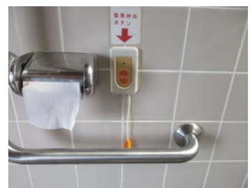
4号トイレ呼出 押しボタン 取替後
