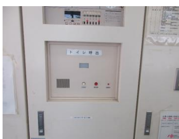
南管理棟 呼出装置 (野と花・花プロ) 取付前
