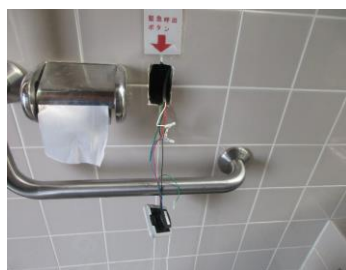
4号トイレ呼出 押しボタン 取替中
