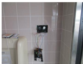
4号トイレ呼出 呼出表示装置 取替中
