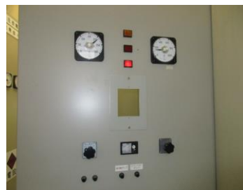
QB 低圧動力用 LGR 取替中
