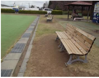
降雨後の状況
