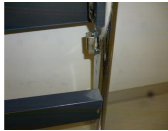
着手前状況拡大
