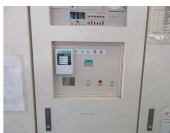
南管理棟 呼出装置 (野と花・花プロ) 取付後
