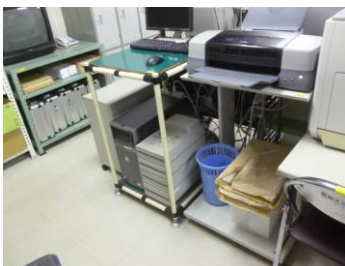
無停電電源装置
