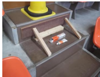
シート復旧状況
