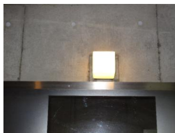
男子トイレ洗面台上 ランプ取替後
