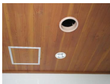
多目的トイレ天井ランプ取替前
