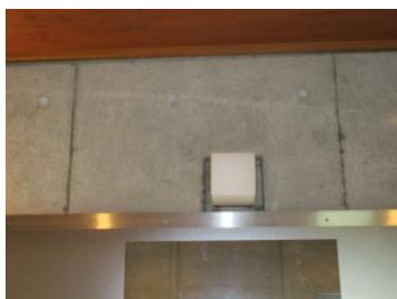
男子トイレ洗面台上 ランプ取替前
