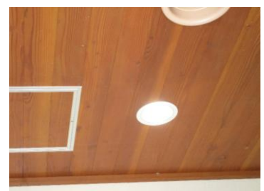
多目的トイレ天井ランプ取替後
