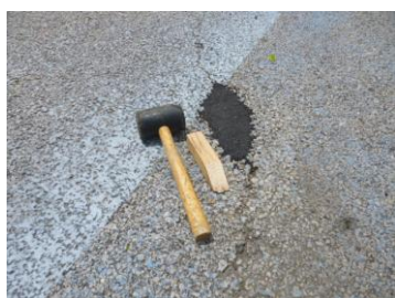
常温合材打設
