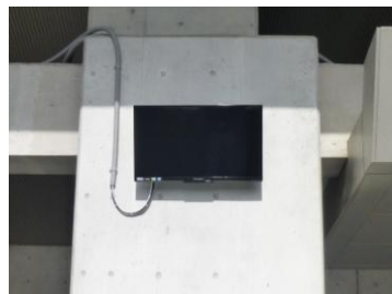
テレビ取付完了 W4 入口
