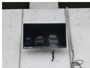
テレビ取付状況
