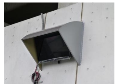
テレビカバー取付状況
