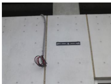
テレビ取付金具取付状況
