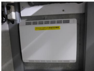
中継器取付完了
