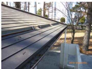
14号トイレ完了
