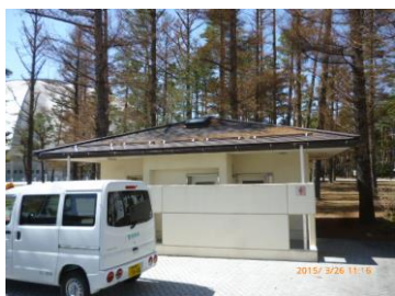
14号トイレ着手前
