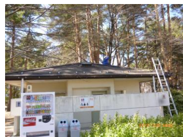
14号トイレ清掃状況
