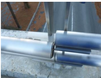
内部パイプ納まり調査
