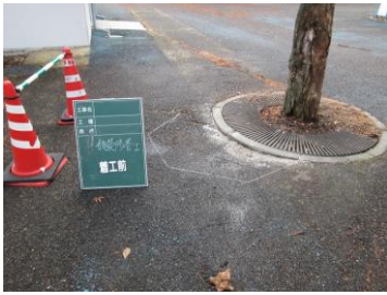
11号トイレ周辺段差着工前
