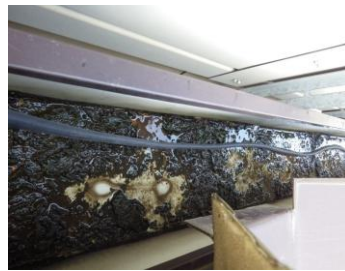
横樋ヒーター設置
