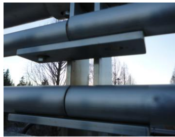
下部パイプボルト脱落
