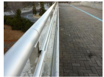
下部パイプぐらつき確認
