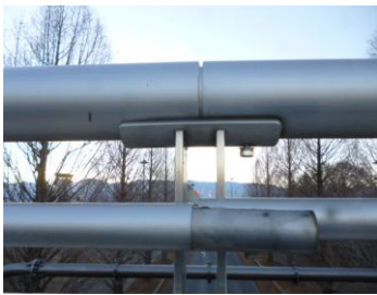
上部欄干ボルト脱落
