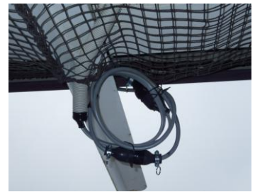
ヒーター接続部
