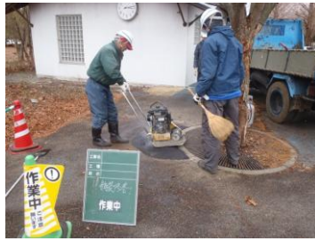
11号トイレ周辺段差作業中
