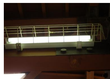
蛍光灯器具交換完了
