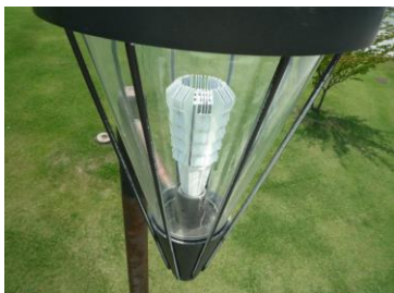
LED 球取付完了状況
