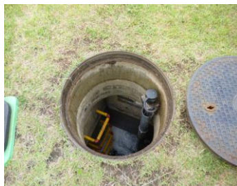
電極取付状況
