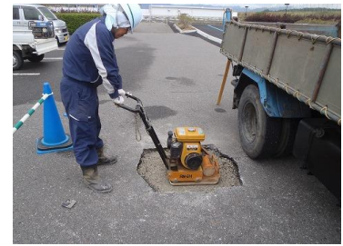
路盤不陸転圧
