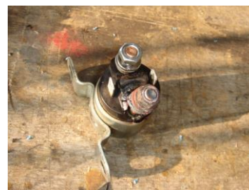
焼損した電磁開閉器
