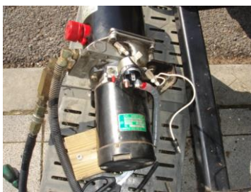
新品の開閉器と作り直した電線類
