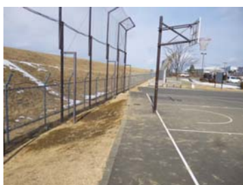
コート汚れ状況
