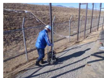
プレートランマー填圧
