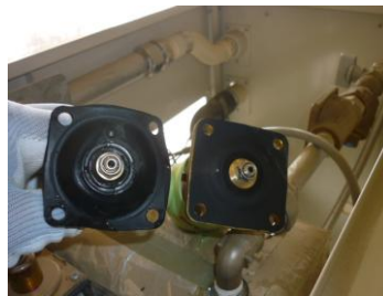
電磁弁要部セット交換
