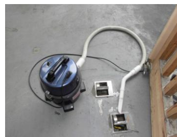
清掃・金具修正・給油
