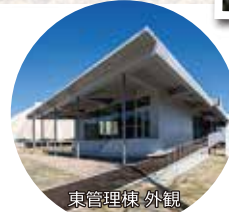
東管理棟 外観
