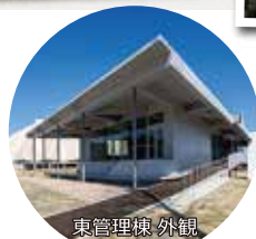
東管理棟 外観
